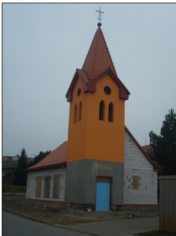
Foto č. 2 Zazimovaná stavba kaple Sv. Antonína Paduánského
